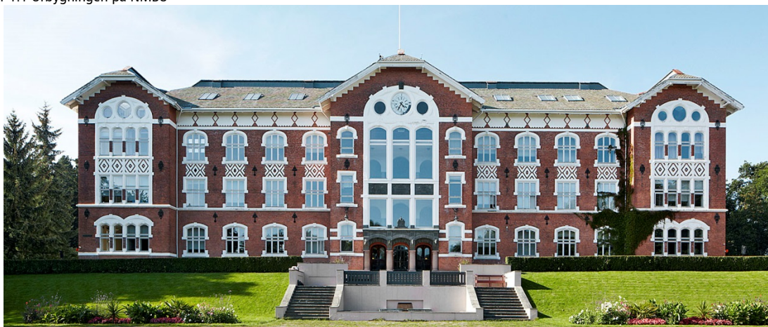
Figur 1.1 Urbygningen på NMBU 4
